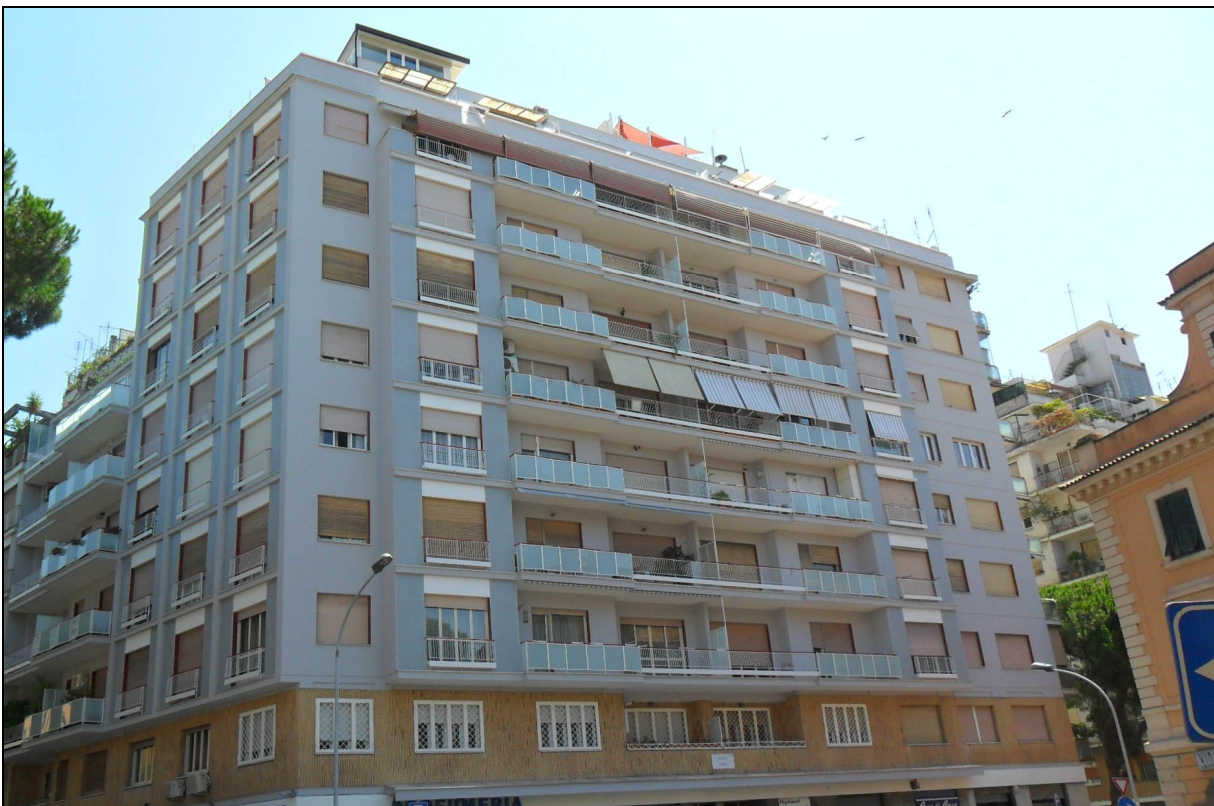
Restauro prospetti Piazza Pompei n. 10 - Roma dopo i lavori
