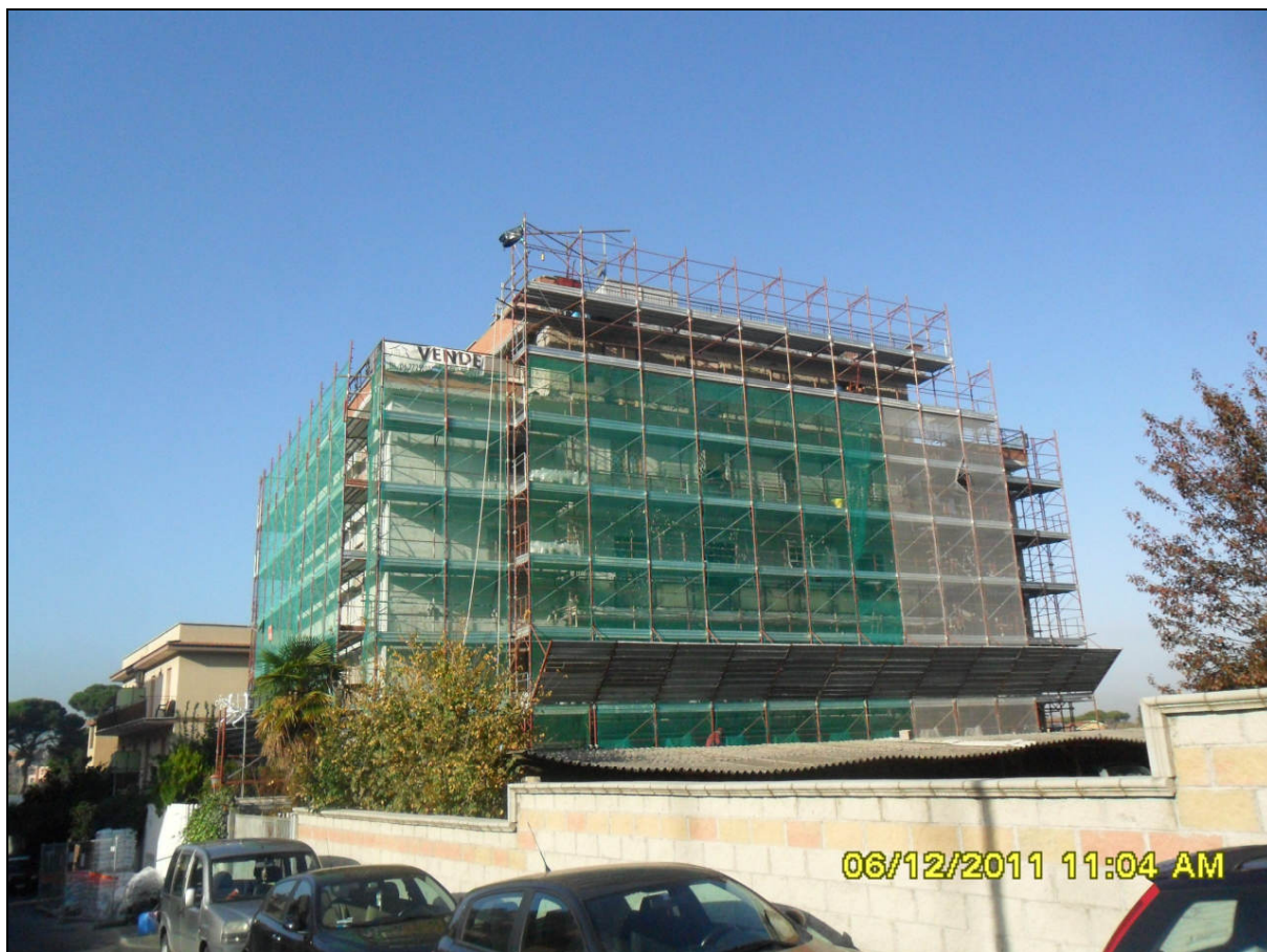
Restauro dei prospetti edificio sito in via Macchi 94 - Roma durante i lavori
