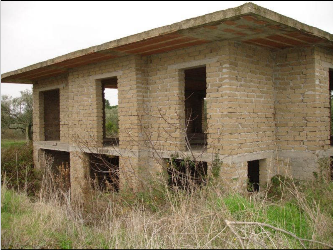
Consolidamento strutturale e restauro edificio in Cesano di Roma prima dei lavori
