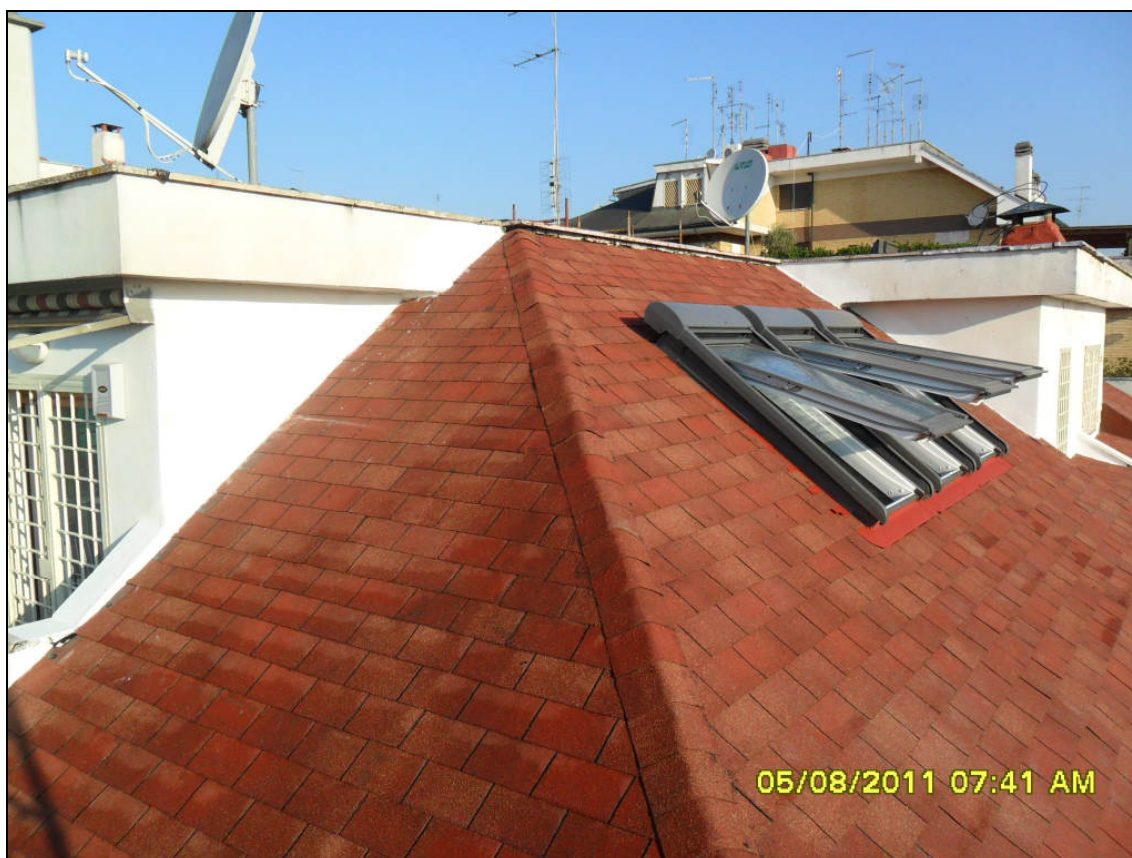
Sostituzione copertura edificio sito via Renato Fucini 242 - Roma dopo i lavori
