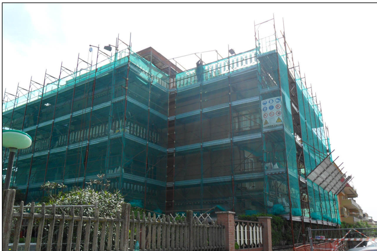
Restauro dei prospetti e consolidamento strutturale edificio sito in via Svezia 313 - Torvajonica in corso
