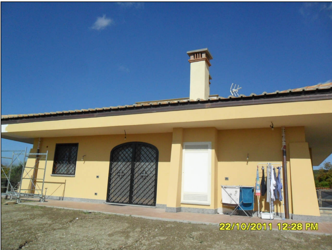
Consolidamento strutturale e restauro edificio in Cesano di Roma dopo i lavori
