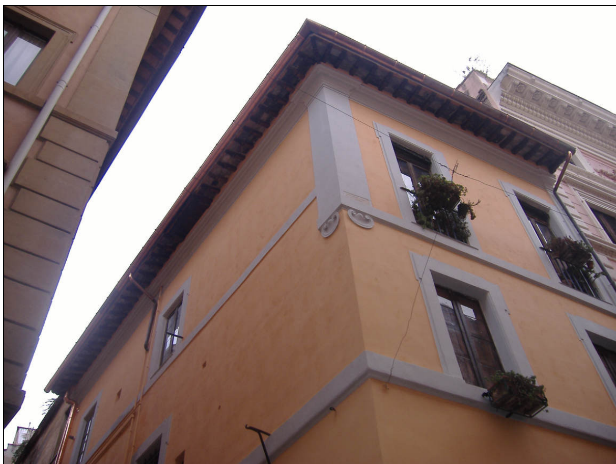
Restauro prospetti via De' Gigli d'Oro 87 - Roma prima dei lavori
