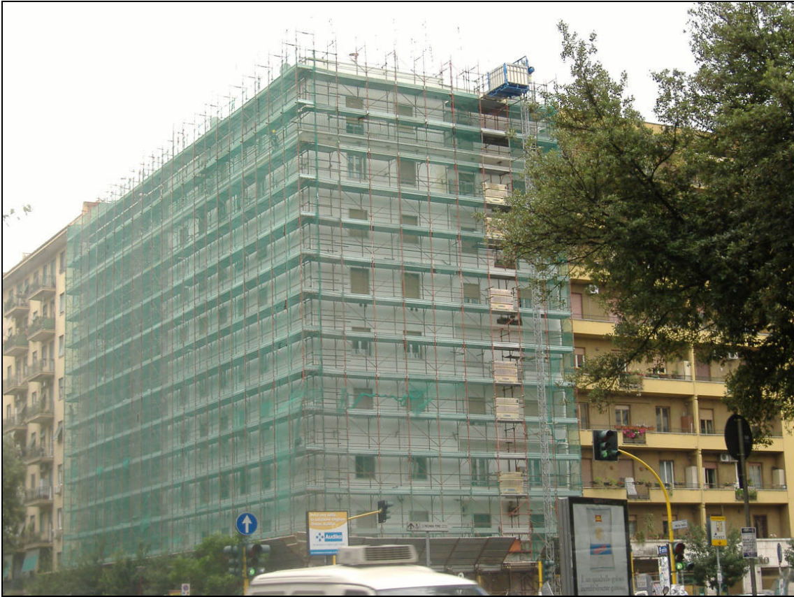
Piazza della Radio durante i lavori - Roma
