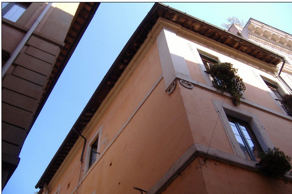
Restauro prospetti via De' Gigli d'Oro 87 - Roma prima dei lavori
