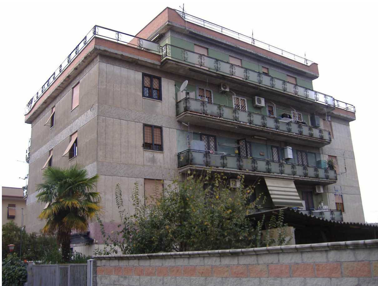
Restauro dei prospetti edificio sito in via Macchi 94 - Roma prima dei lavori
