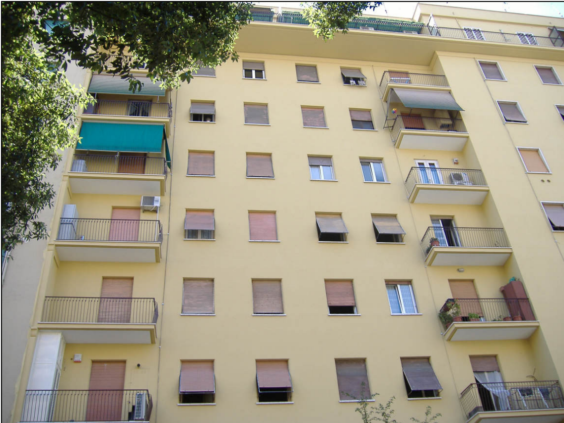
Piazza della Radio dopo i lavori - Roma
