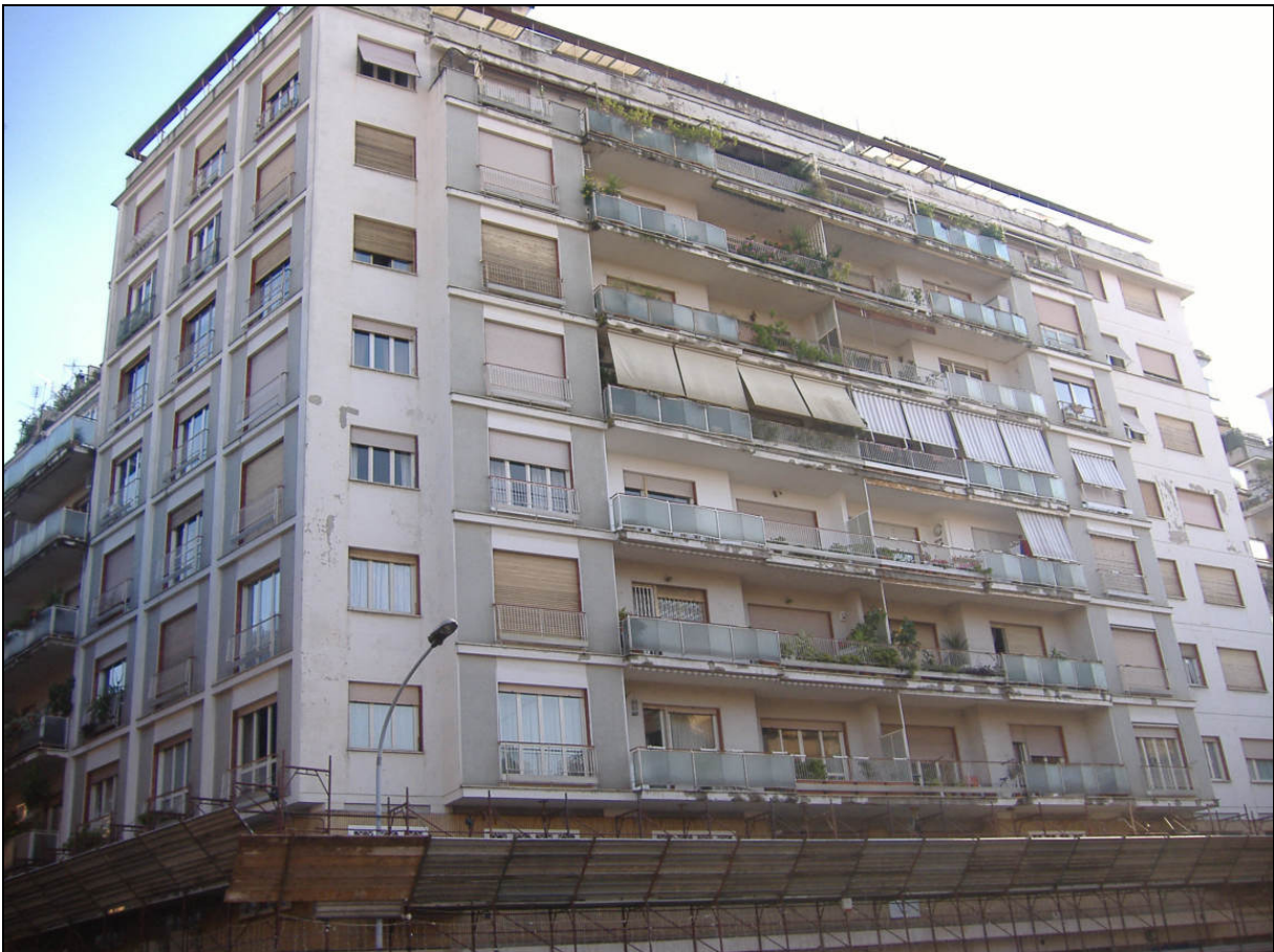
Restauro prospetti Piazza Pompei n. 10 - Roma prima dei lavori
