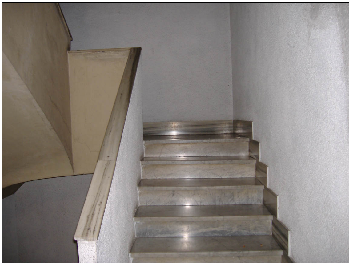
Restauro del vano scala Condominio via di S.M. Ausiliatrice 87 - Roma prima dei lavori
