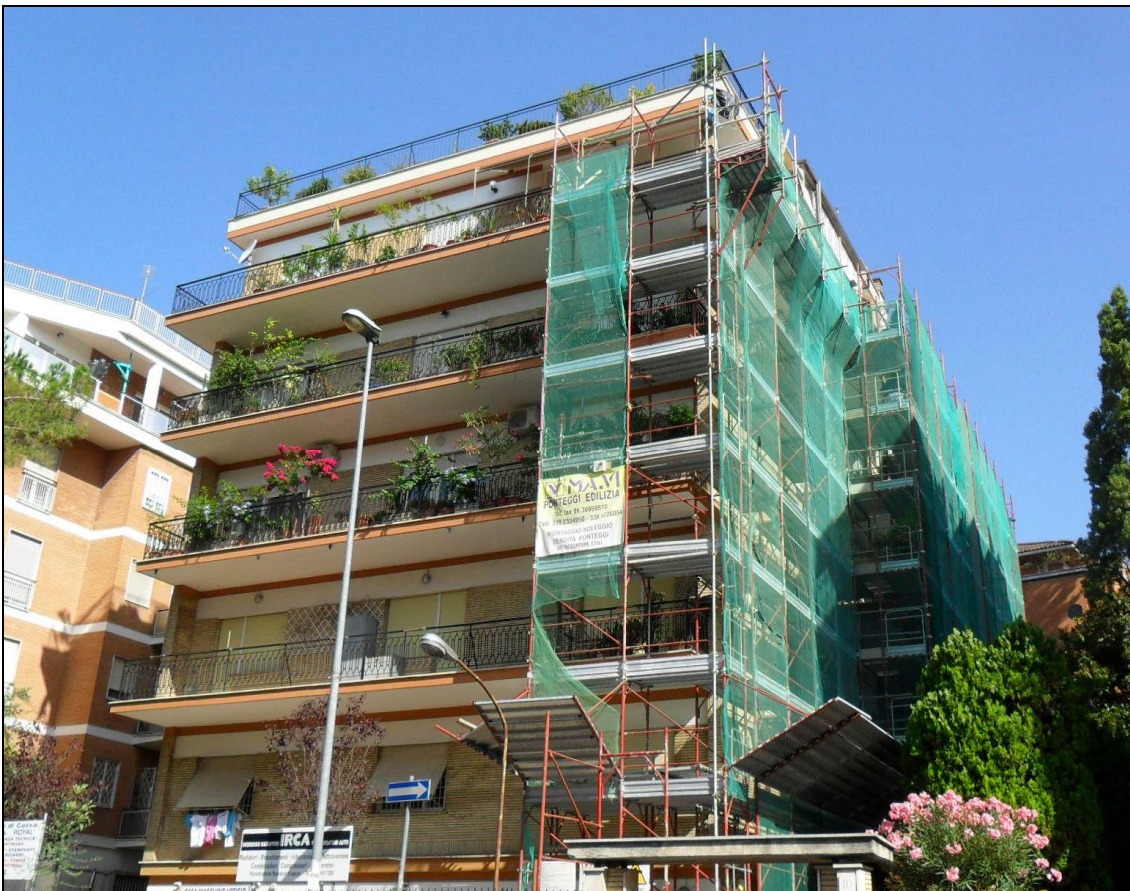
Restauro prospetti via Fulvio Maroi 10 - Roma durante i lavori
