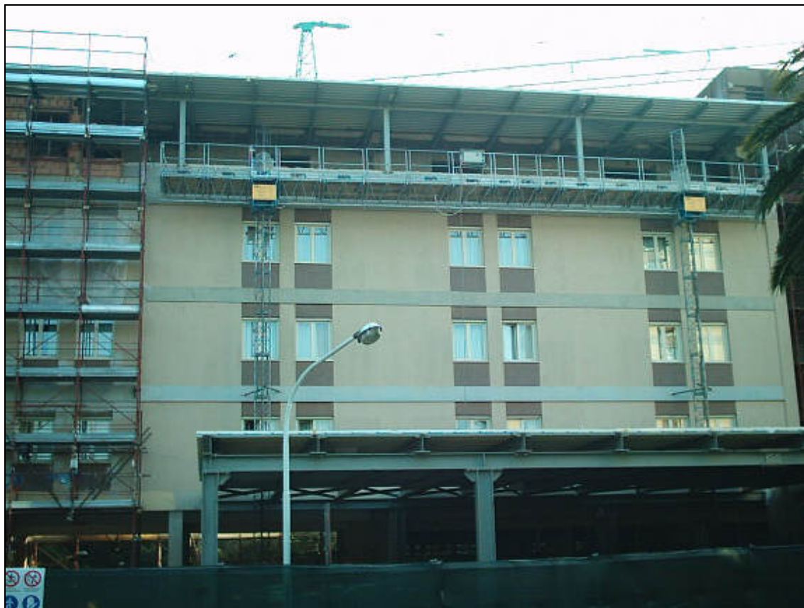
Restauro prospetti e sopraelevazione albergo Holiday Inn - Roma
