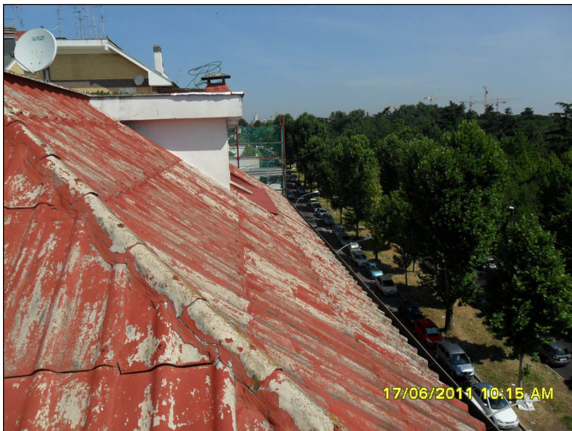
Sostituzione copertura edificio sito via Renato Fucini 242 - Roma prima dei lavori
