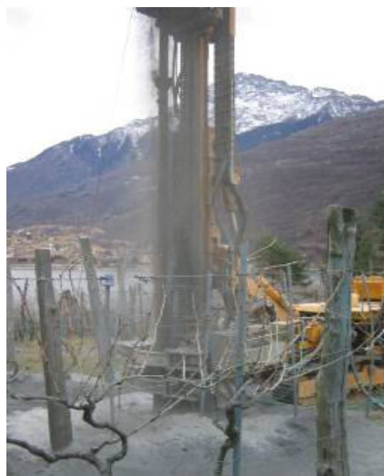
Realizzazione pozzo abbazia di Piona
