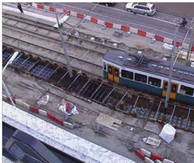
Restauro banchina della metropolitana
