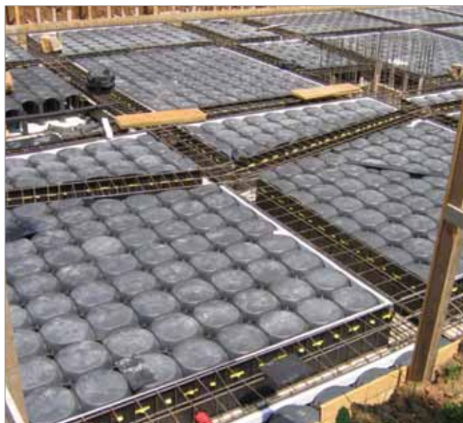
Sistema Atlantis in combinazione con Cassaforma Muro
