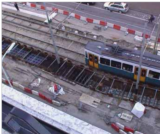
Restauro banchina della metropolitana
