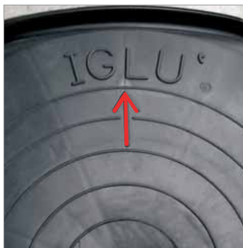
fig. 1 - Posa a secco del primo cassero, la freccia è rivolta verso il cordolo di fondazione
