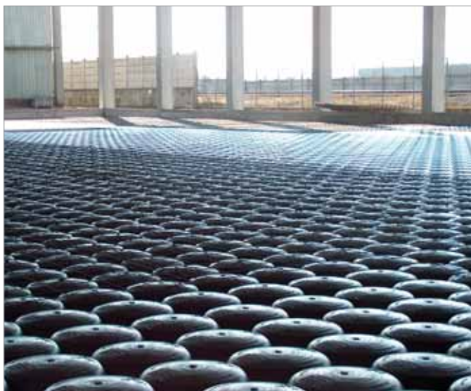
Intercapedine ventilata per edificio ad uso industriale
