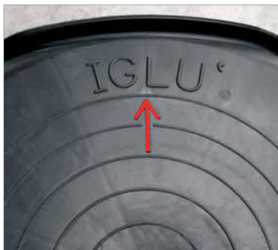
Fig. 1 - Posa a secco del primo cassero, la freccia è rivolta verso il cordolo di fondazione.
