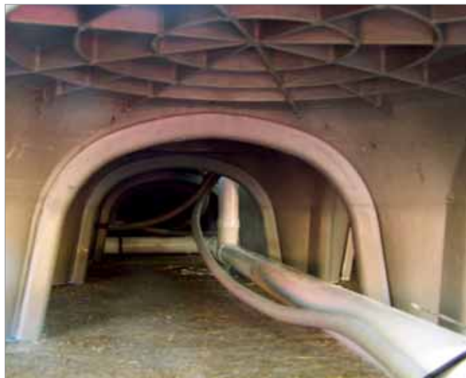
Esempio di passaggio utenze
