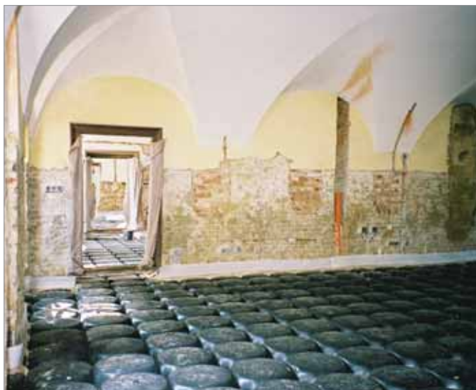
Restauro edificio storico
