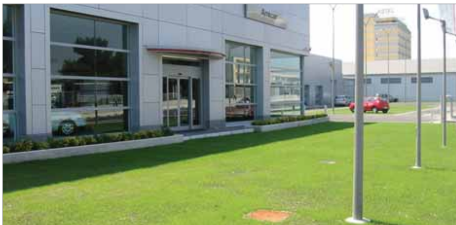
Area di posteggio in ambito industriale
