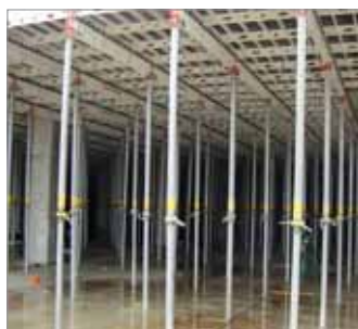
Particolari fotografici della sequenza completa di posa in opera: realizzazione dell'impalcato, posa di U-Boot Beton ® e dell'armatura della struttura, getto e lisciatura finale.
