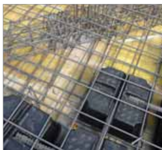
Particolari fotografici della sequenza completa di posa in opera: realizzazione dell'impalcato, posa di U-Boot Beton ® e dell'armatura della struttura, getto e lisciatura finale.
