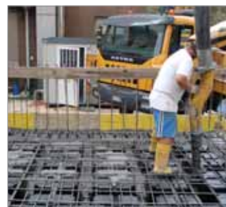
Particolari fotografici della sequenza completa di posa in opera: realizzazione dell'impalcato, posa di U-Boot Beton ® e dell'armatura della struttura, getto e lisciatura finale.
