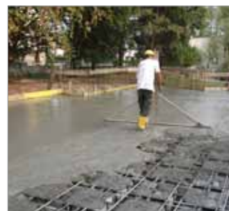
Particolari fotografici della sequenza completa di posa in opera: realizzazione dell'impalcato, posa di U-Boot Beton ® e dell'armatura della struttura, getto e lisciatura finale.
