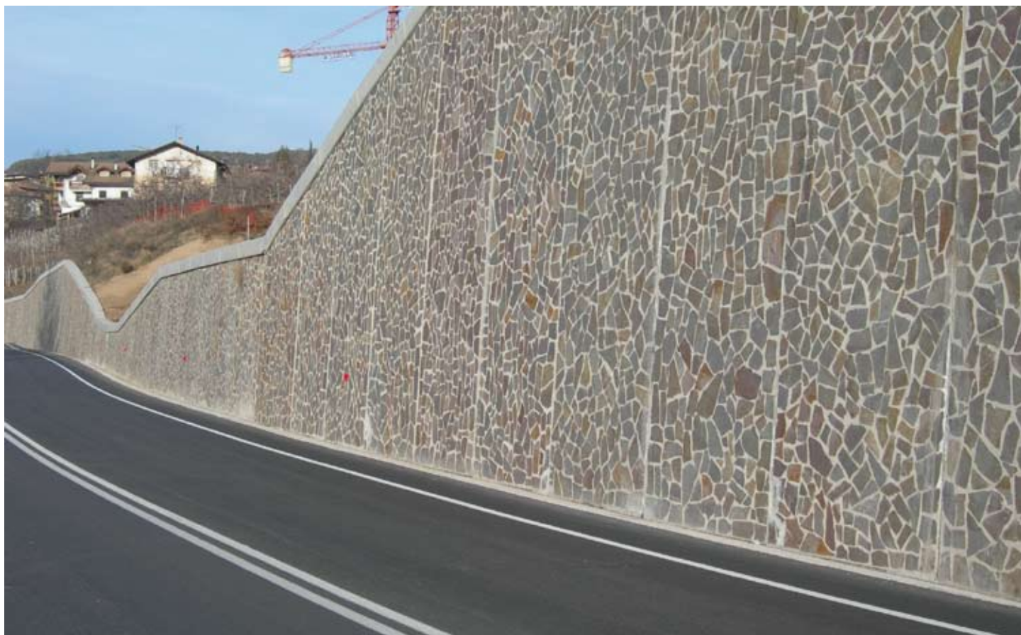
Muro di sostegno con rivestimento esterno in Porfido.
