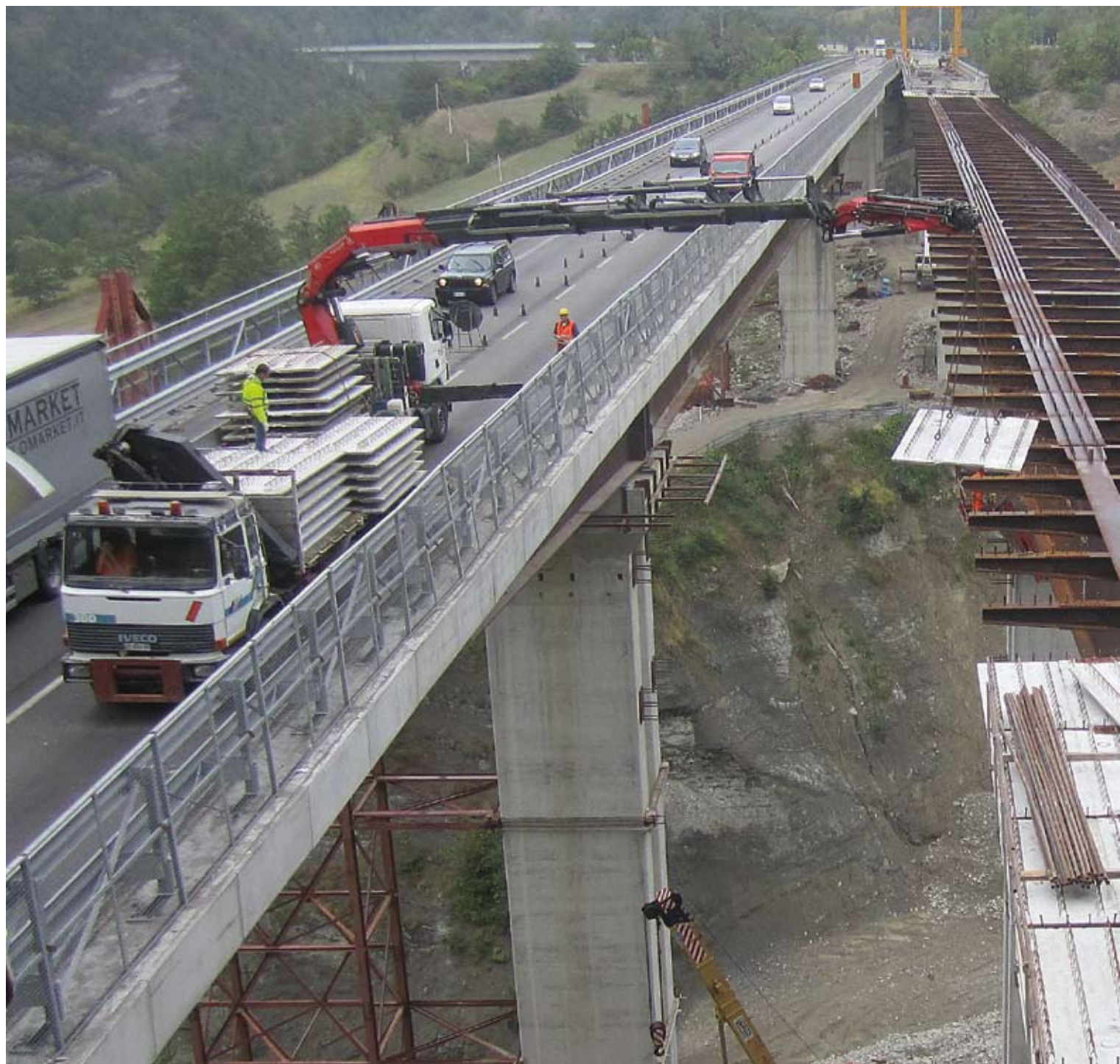
Posa in opera predalles su impalcati con travi in acciaio.
