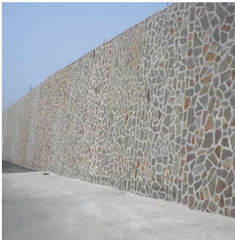
Muro di sostegno con rivestimento esterno in Porfido.
