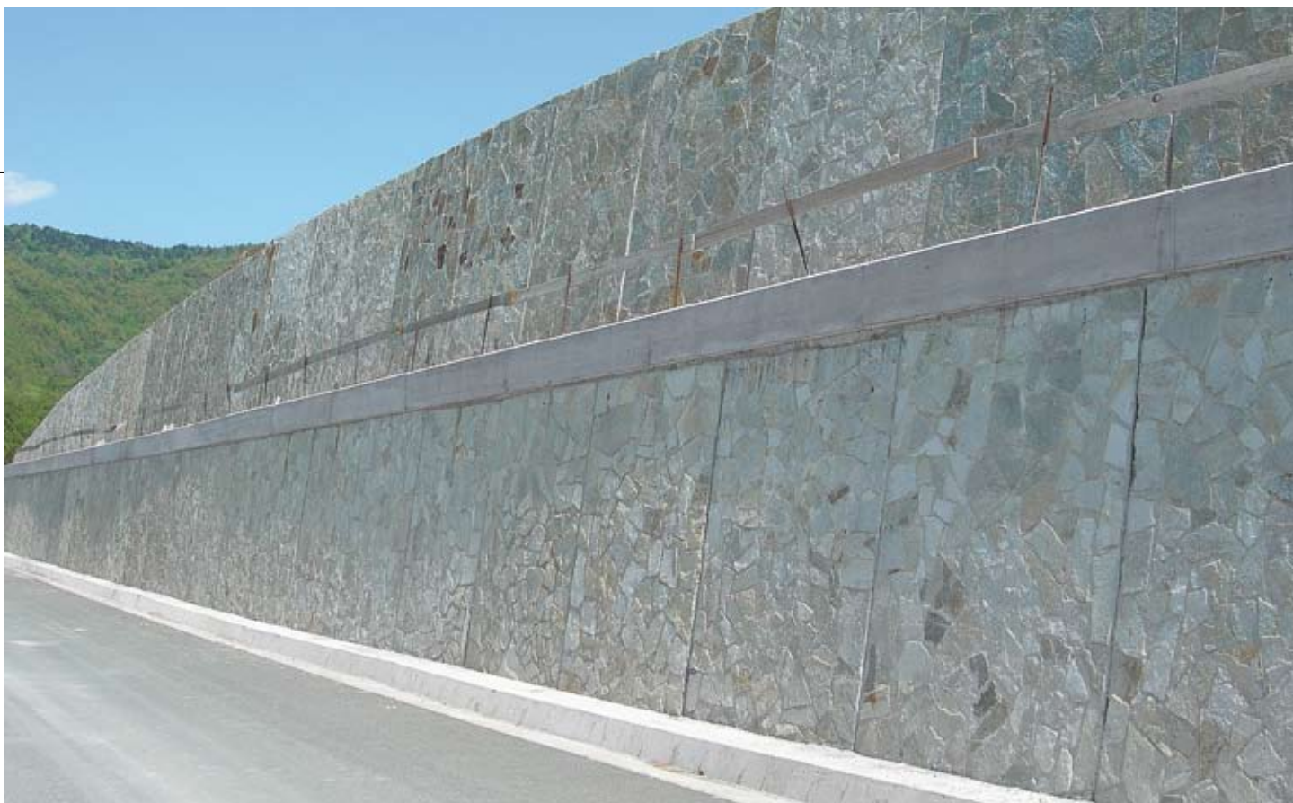
Muro di sostegno con rivestimento esterno in pietra di Luserna.
