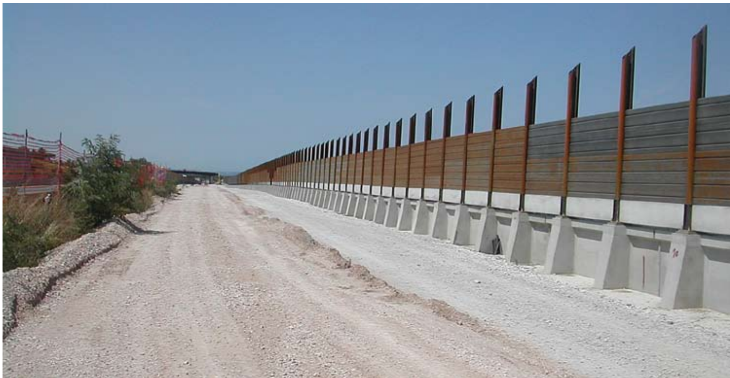
Muri di sostegno per barriere antirumore - Autostrada A14 Senigallia (AN).
