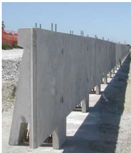
Muro di sostegno porta barriere fonoassorbenti.
