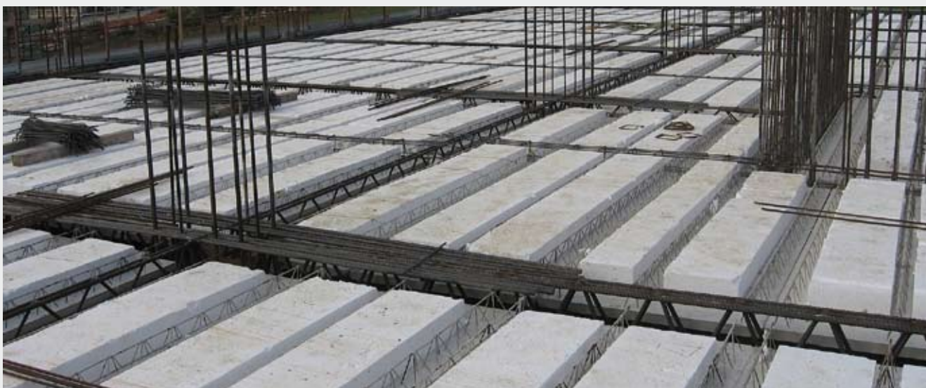
Impalcati realizzati con lastre bausta.
