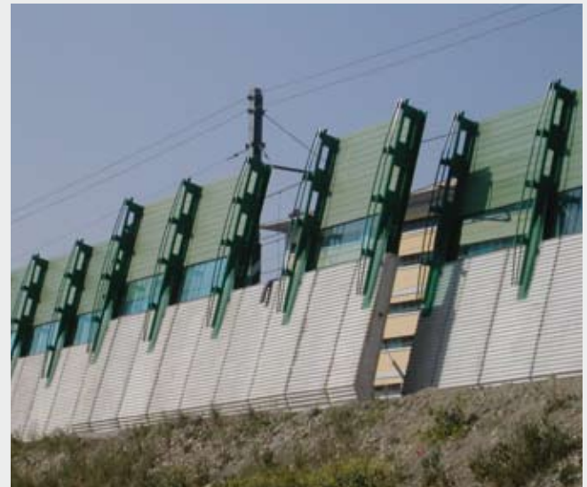
Barriere antirumore ferroviarie realizzate con basamenti HS
