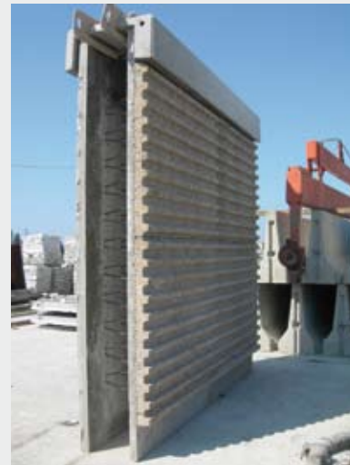
Doppie lastre rivestite da un lato in pietra e dall'altro con materiale fonoassorbente.
