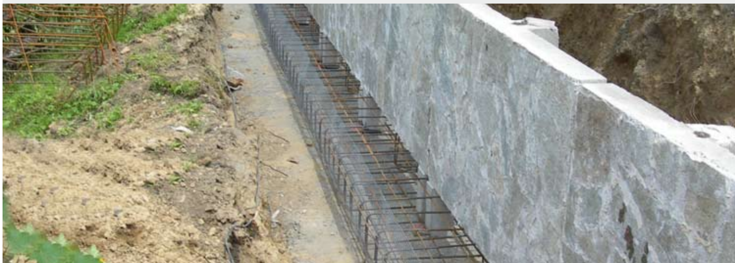
Muro di sostegno con rivestimento esterno in pietra di Luserna con fondazione passante.
