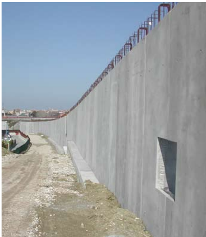
Muri di sostegno a facciata liscia.
