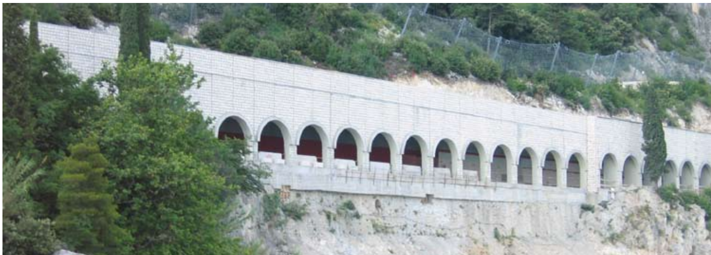
Lastre di rivestimento galleria artificiale in pietra locale in località Riva del Garda (TN)
