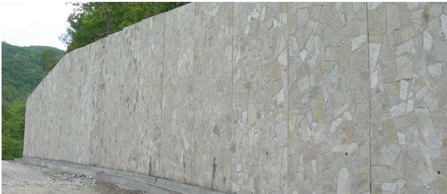
Muro di sostegno con rivestimento esterno in pietra di Luserna.
