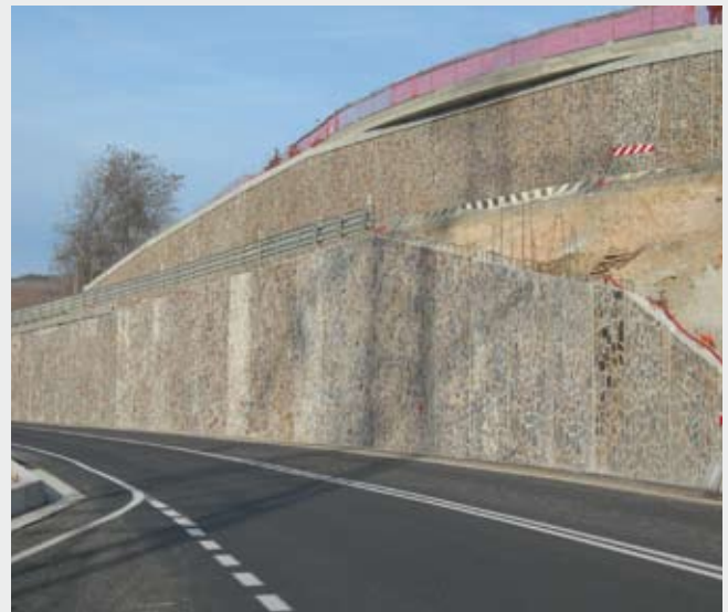
Lastre di rivestimento con pietra irregolare.
