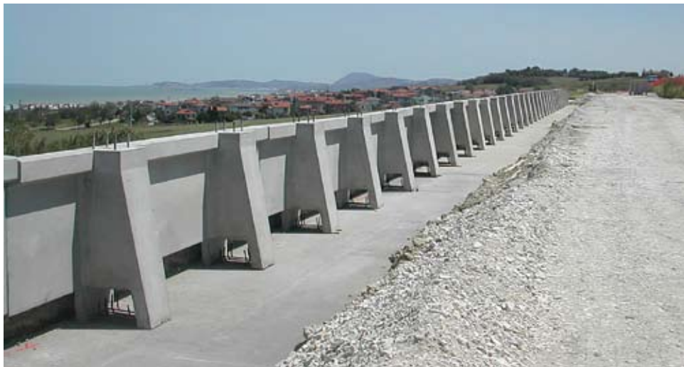
Muro di sostegno porta barriere fonoassorbenti lato piattaforma stradale.
