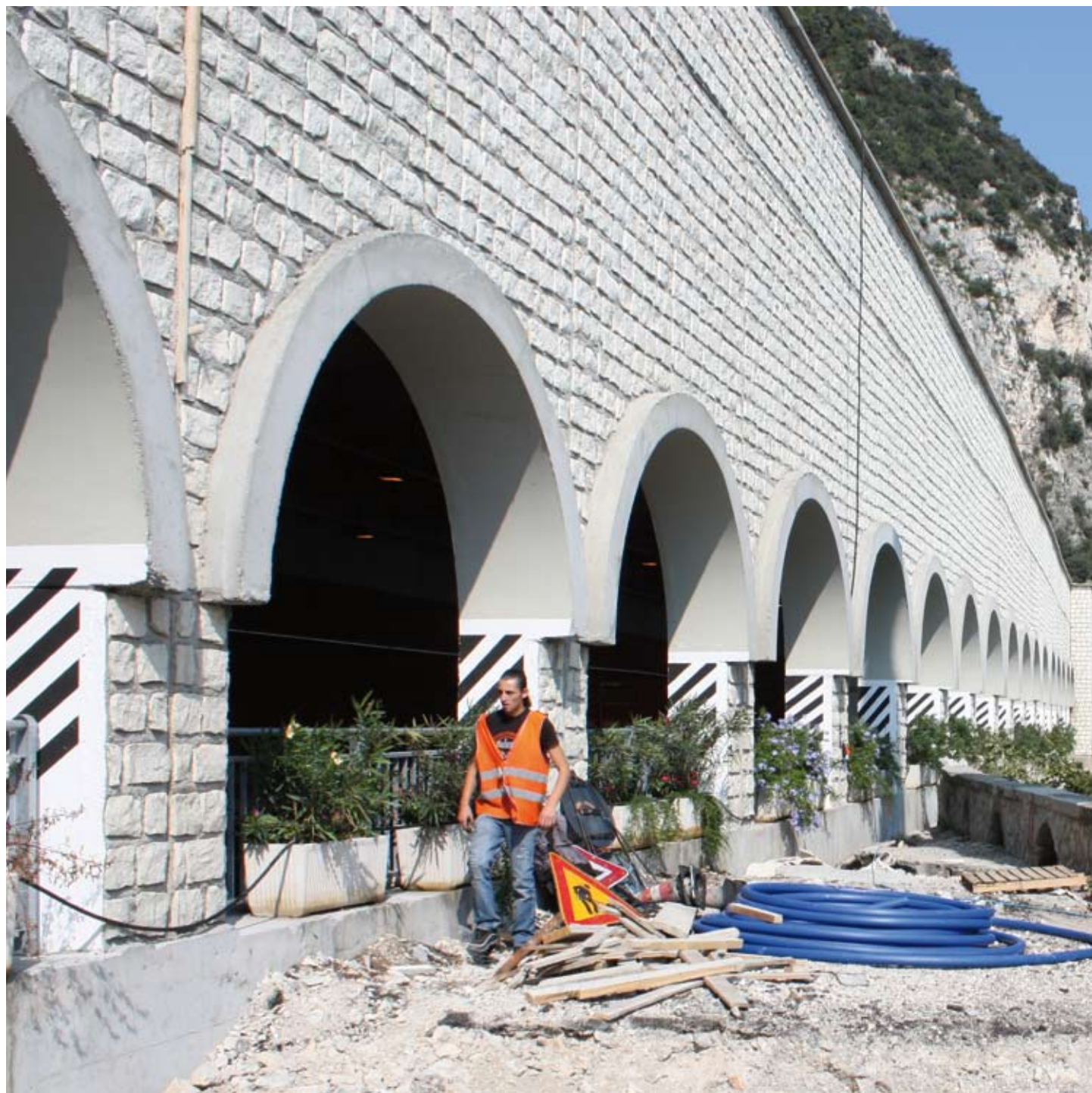
Lastre di rivestimento galleria artificiale in pietra locale in località Riva del Garda (TN)
