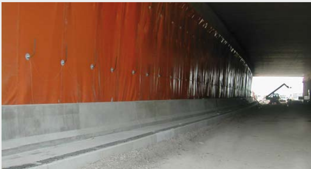
Profilo redirettivo per protezione piedritti delle gallerie.
