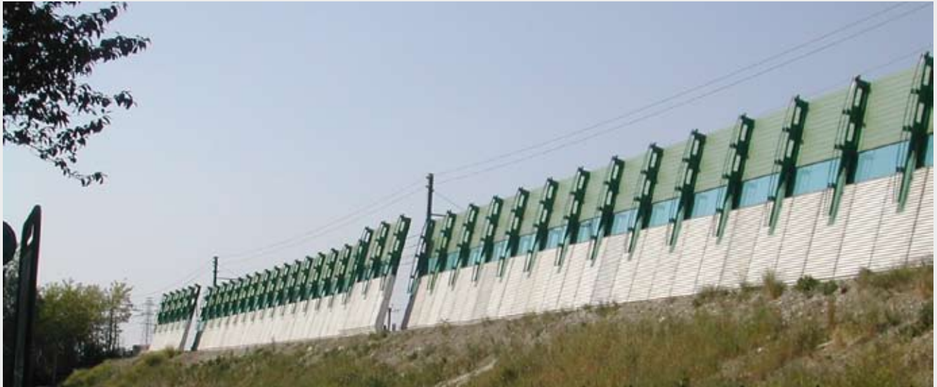
Barriere antirumore ferroviarie realizzate con basamenti HS
