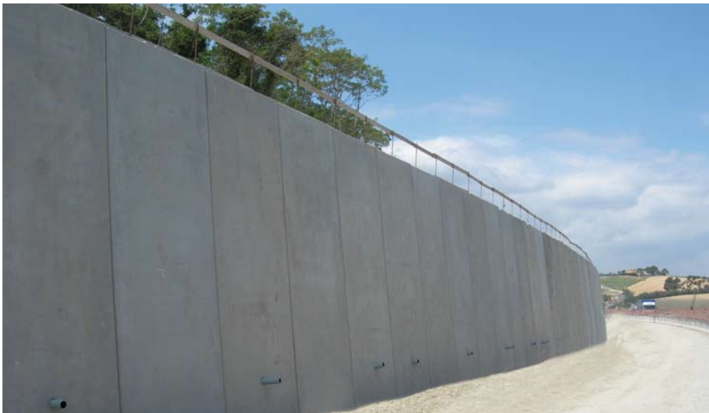
Lastre di rivestimento paratie di pali - Autostrada A14 Senigallia (AN).
