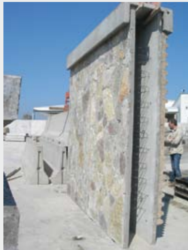
Doppie lastre rivestite da un lato in pietra e dall'altro con materiale fonoassorbente.
