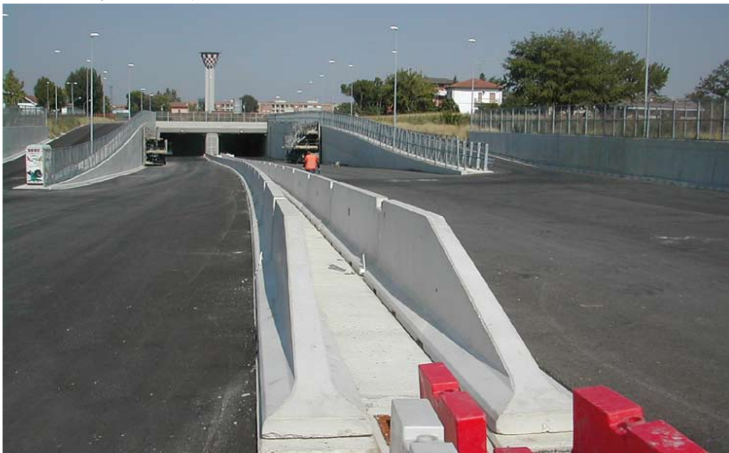
Barriere stradali - asse di arroccamento nuova Tangenziale di Forlì
