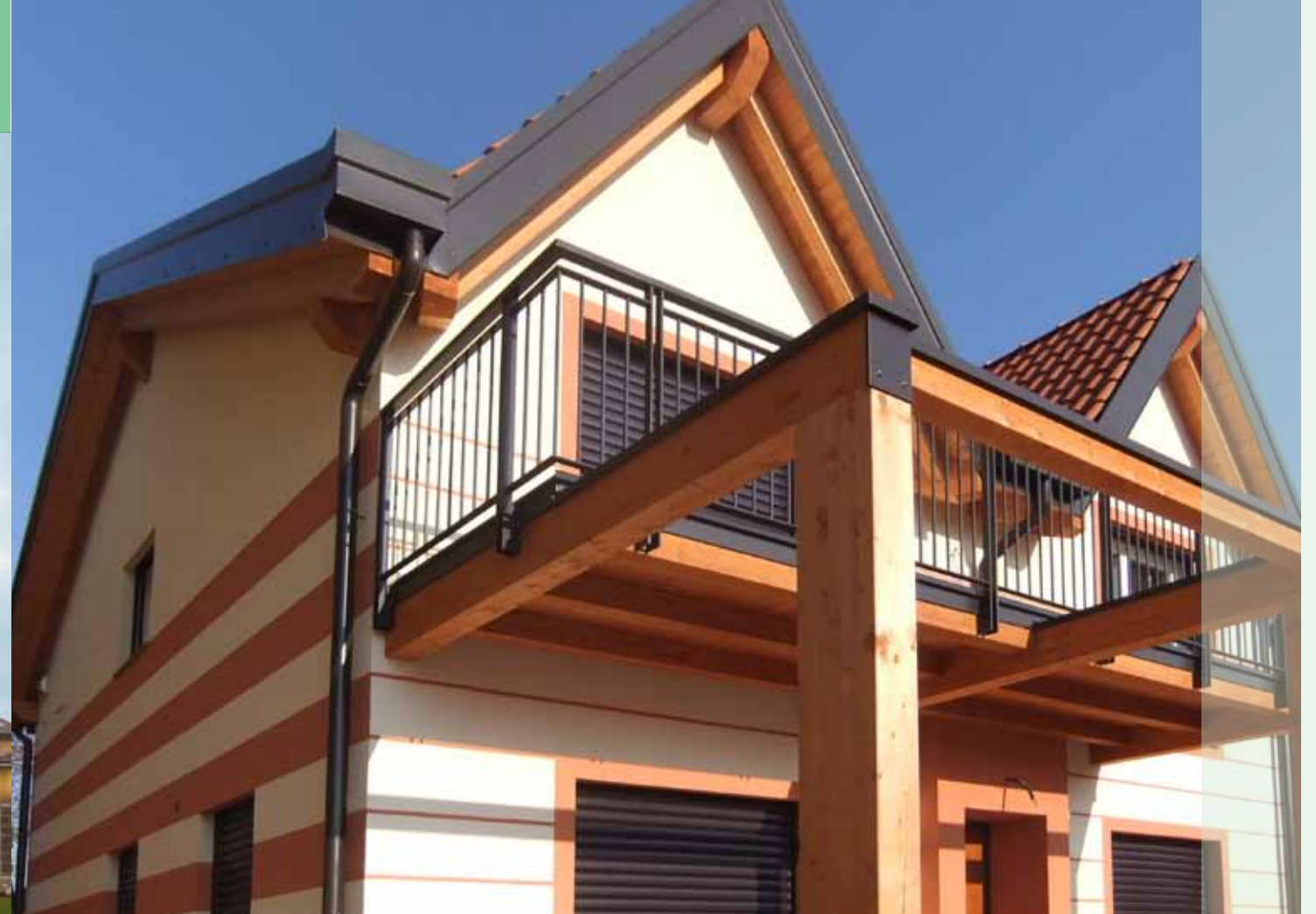
Studio Tecnico TEKNA Engineering
