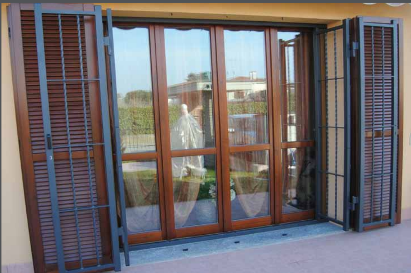
Le quattro ante sono completamente aperte e le due esterne vanno in appoggio alle persiane The four shutters are fully open and the two external ones rest on the house shutters
