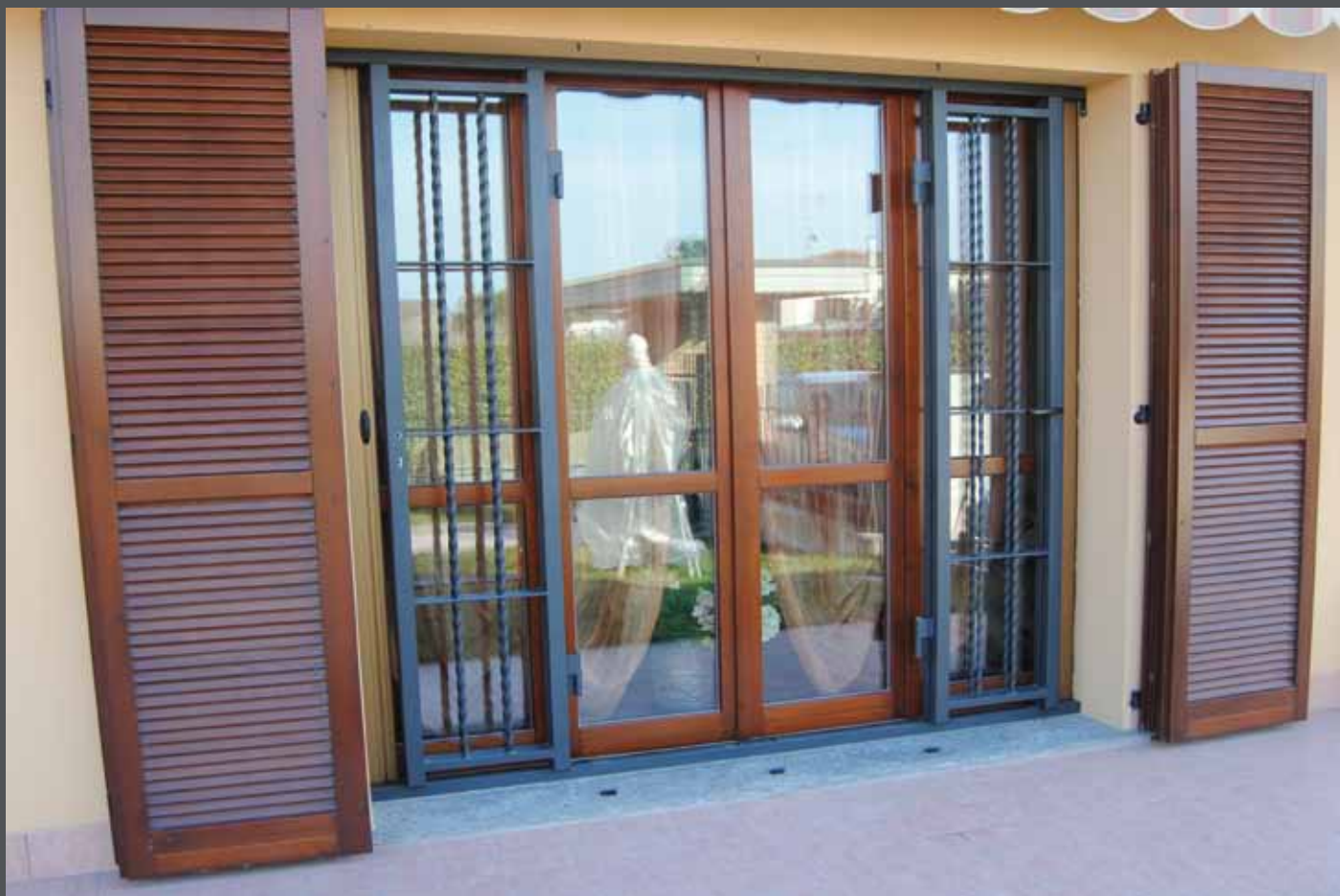
Le ante centrali sono aperte e vanno completamente in appoggio alle laterali The central shutters are open and they rest on the side ones
