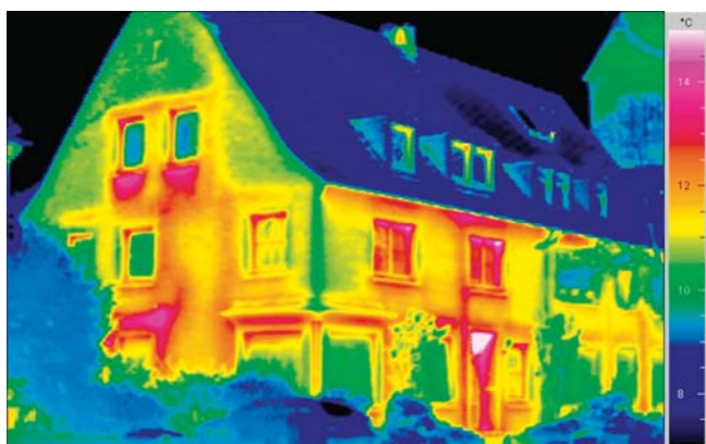
Le foto fatte con camere a infrarossi consentono di individuare i ponti termici di una casa. Foto: Verband Privater Bauherren e. V./ Bundesverband Deutscher Baustoff-Fachhandel e. V.
