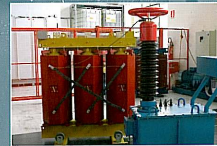
Prova a Tensione Applicata
