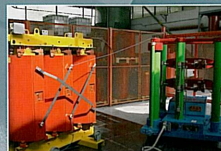
Prova a Impulso Atmosferico (Prova di Tipo)
