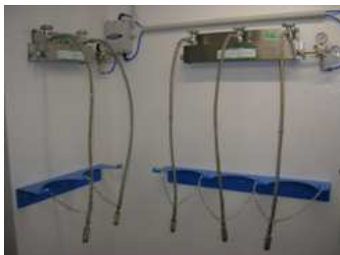
Gruppo di automatico di scambio bombole Cillit
