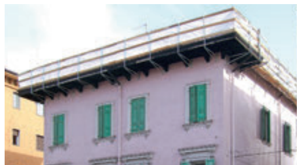
Installazione parapetti temporanei
