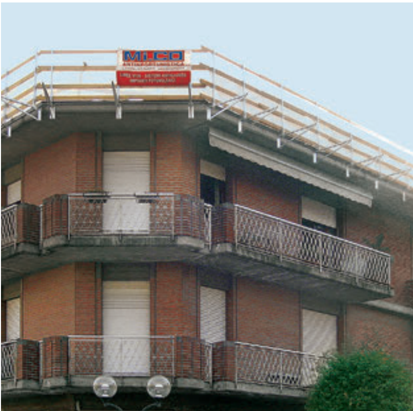
Installazione parapetti temporanei
