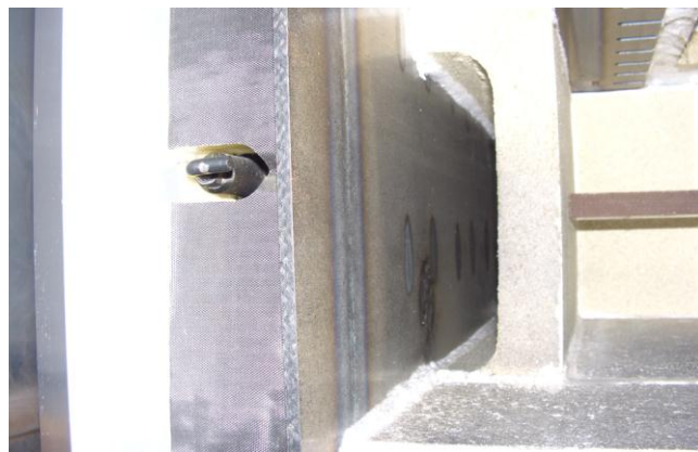
Fig.21- Dettaglio secondo giro fumi in refrattario
