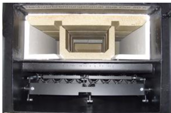
Fig. 16 - Vista dall'alto zona ispezione camera combustione e scambiatori
