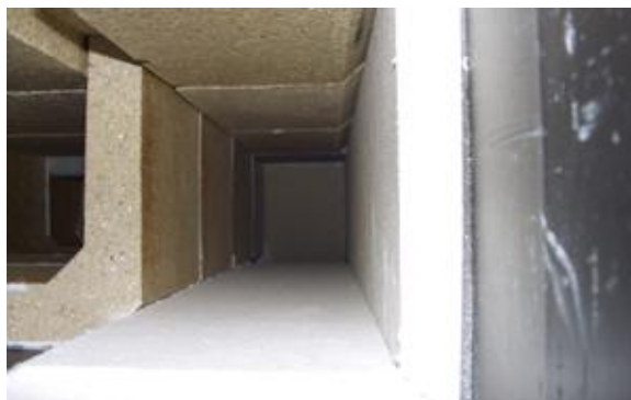
Fig. 18 - Dettaglio secondo giro fumi destro in refrattario
