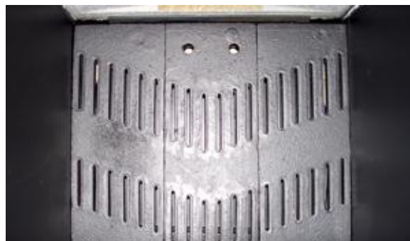
Fig. 14 - Vista dall'alto griglia inferiore in ghisa
