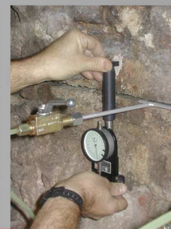
Indagine dello stato tensionale delle strutture:
