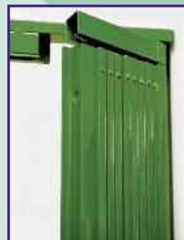
Particolare ribaltamento non necessita muratura
