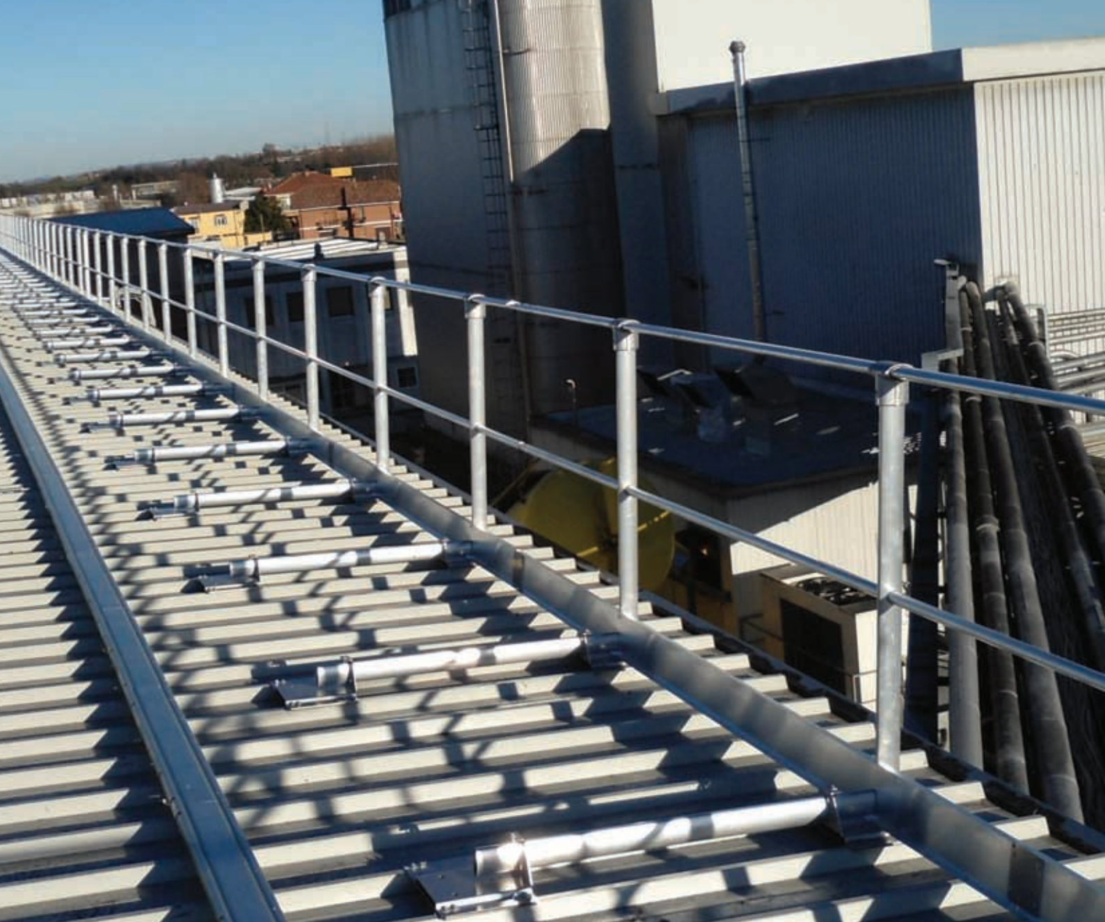
Parapetti in alluminio conformi alla norma EN 14122-3 e NTC08
