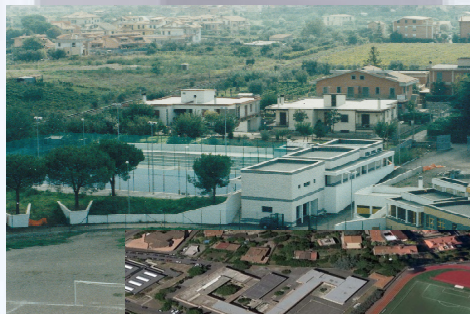
Realizzazione del centro sportivo comunale Ciampino
