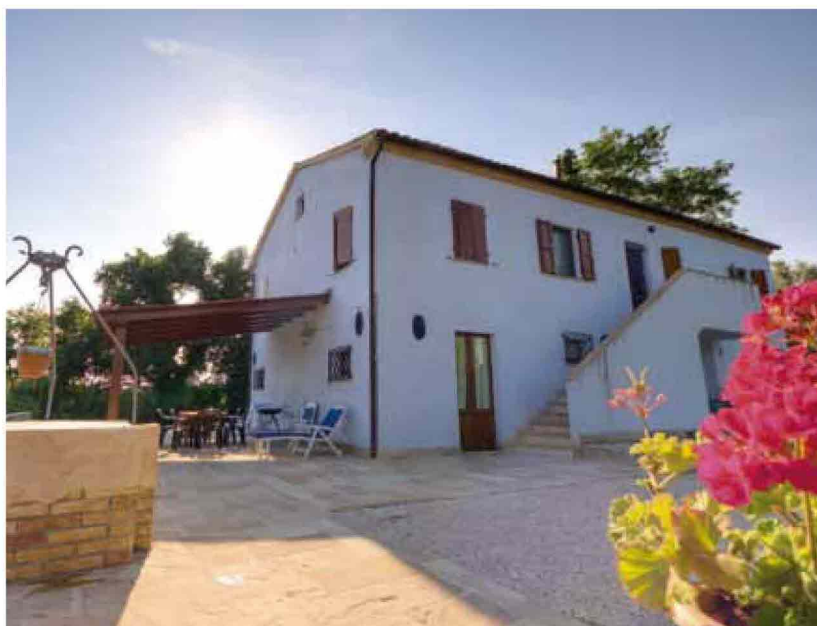
La struttura rientra nella tipologia "grandi impianti" sebbene la potenza installata sia inferiore ai 200 kWp, poiché l'energia prodotta viene ceduta completamente alla rete
