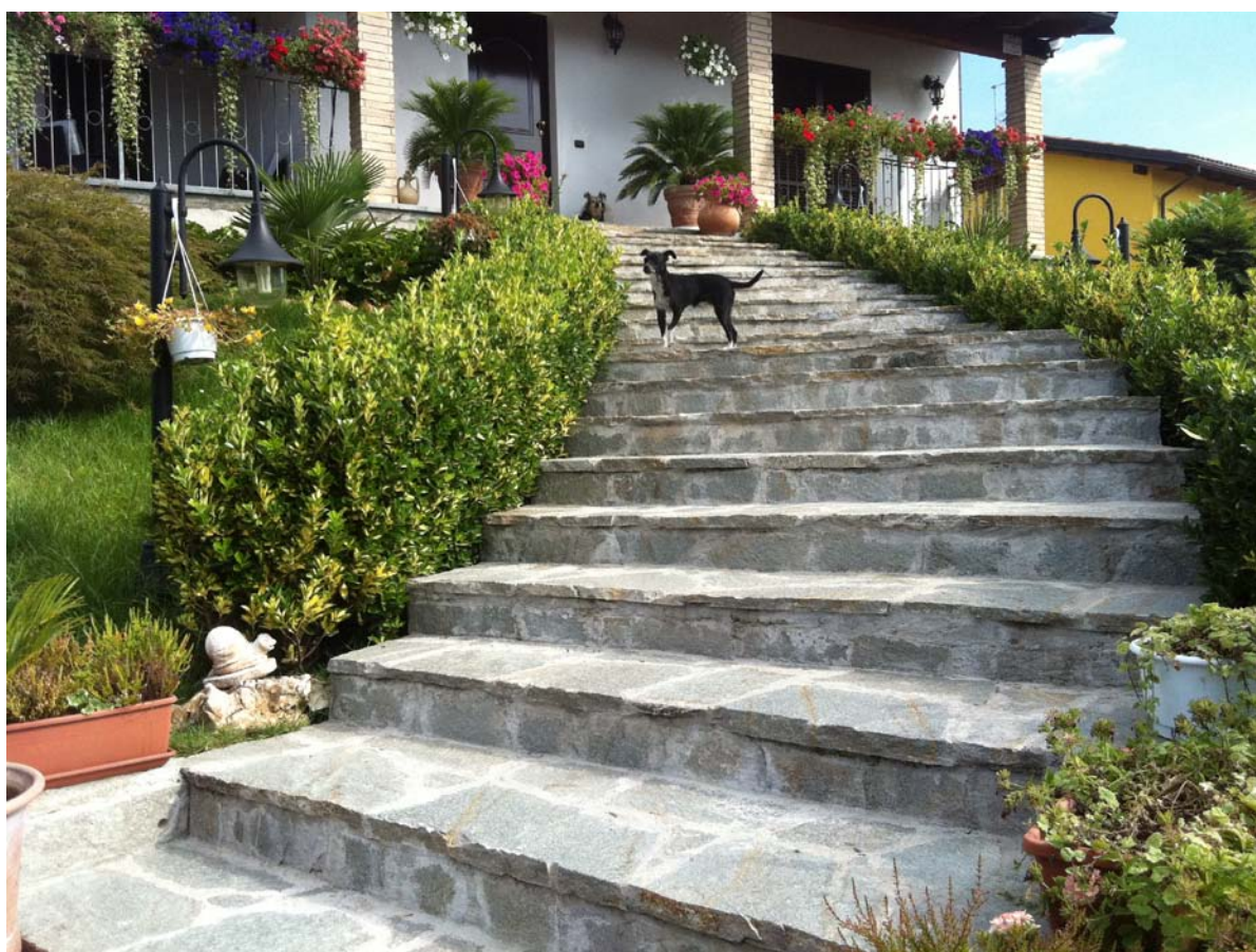
Rivestimento scala esterna in Luserna a spacco
