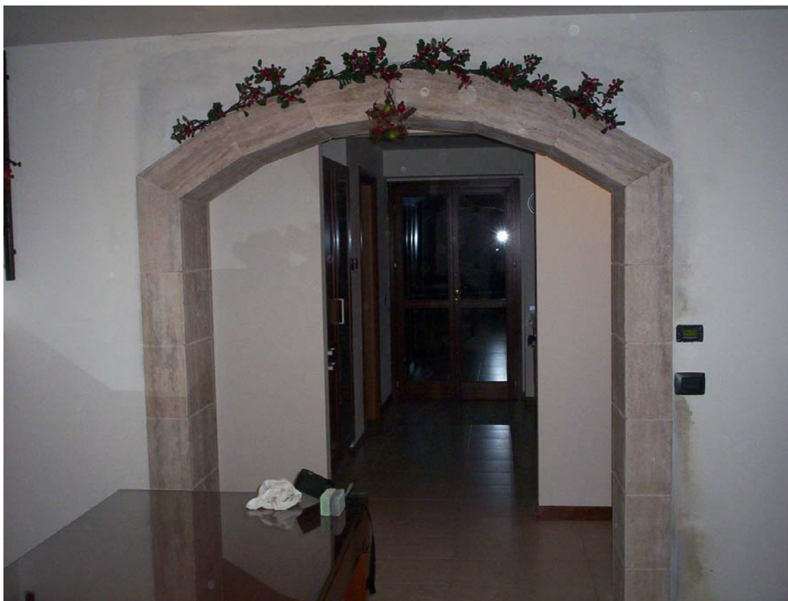
Rivestimento arco e spalle in Travertino levigato
