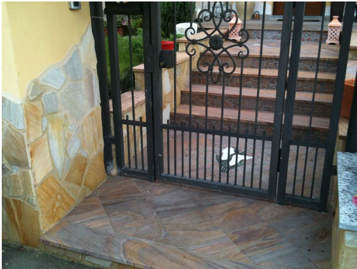
Rivestimento con Opus Incertum in Quarzite Gialla a spacco
